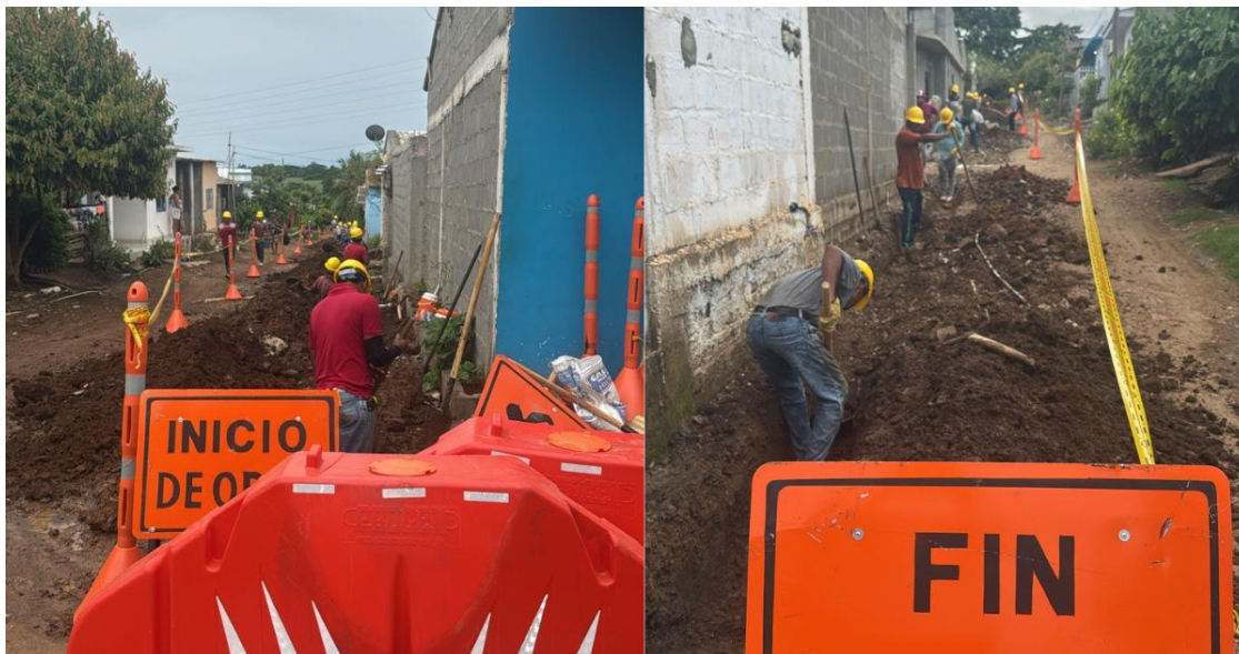
Imagen - obras de la instalación del acueducto en Lórica
