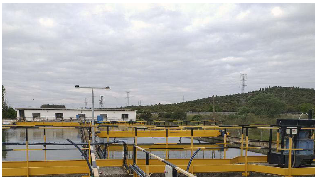
La firma cuenta con estaciones de tratamiento como la de Talavera de la Reina para garantizar la posterior distribución de este recurso a cada casa.
